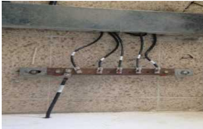
Figura 4.3 Sistema Puesta a Tierra
