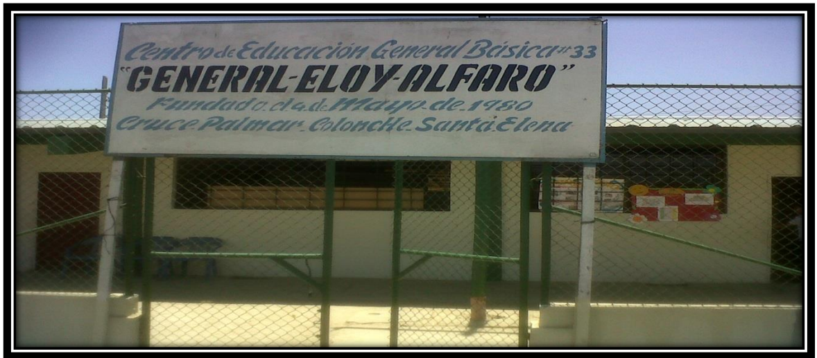
ESTRUCTURA DE LA ESCUELA
