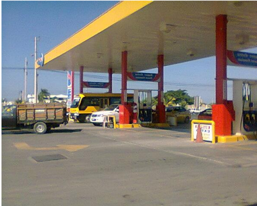
Estación de Servicios Hnos. "Chalén" S.A Char Gasolinera "Hnos. Chalén".
