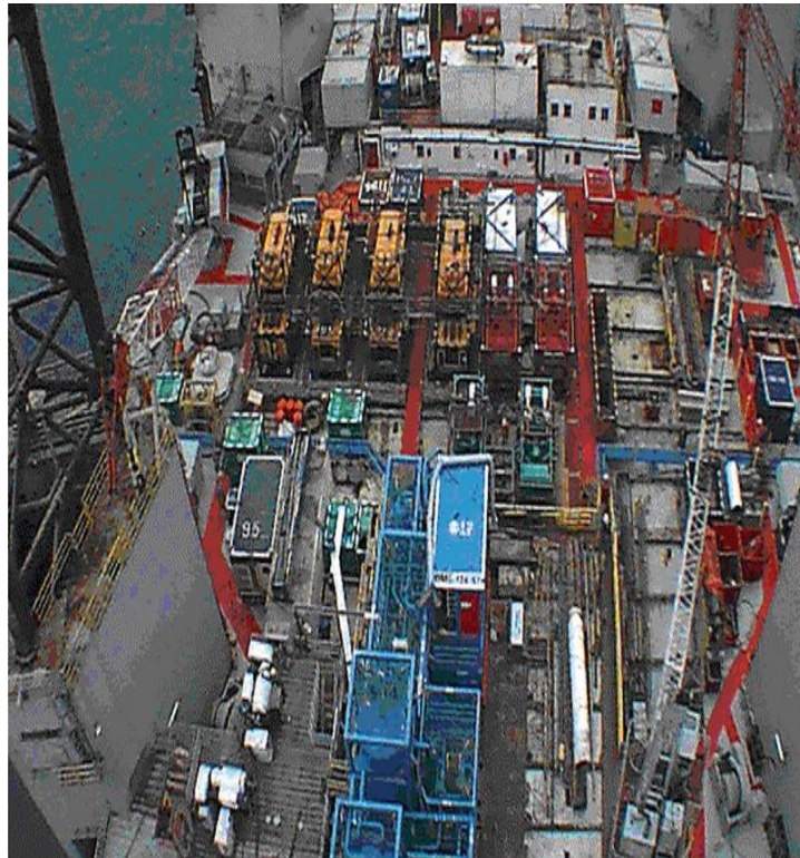
Figura 4.4.- Sistema de generación de nitrógeno en alta mar. Fuente: Introducción a la Perforación Bajo Balance, Weatherford (Enero Del 2006).
