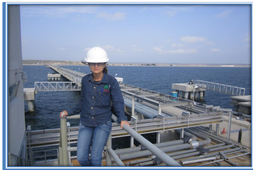
ANEXO 6. Plataforma del muelle
