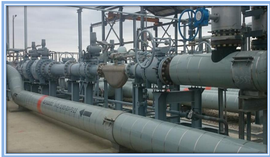
Figura 4 Mezcla y Medición
