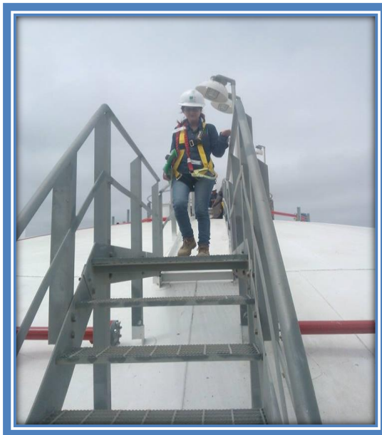
ANEXO 10. Parte superior del tanque Butano
