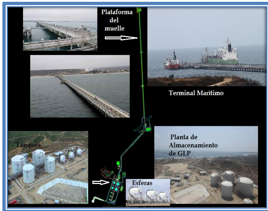
Figura 1 Terminal Marítimo y Planta de Almacenamiento de GLP
