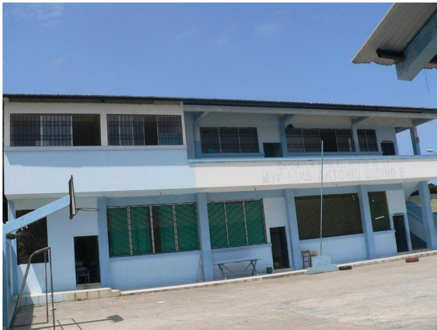
La infraestructura de la institución es adecuada pero con muchas falencias.
