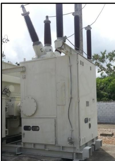
**Figura 10 Disyuntor 69Kv Subestación Manglaralto**
