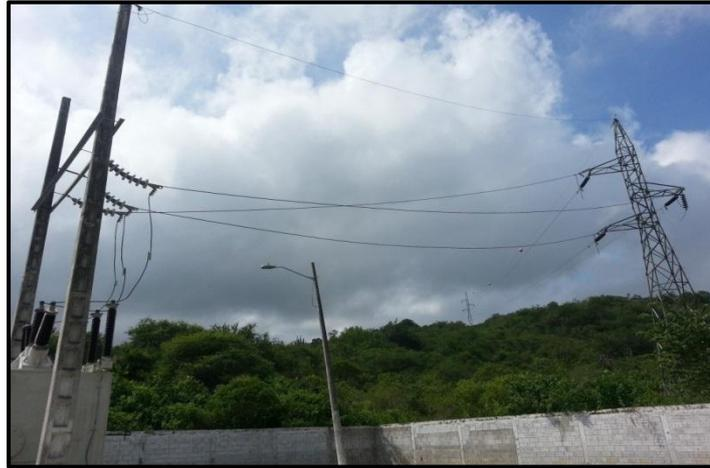
Figura 8 Líneas de transmisión de 69Kv
