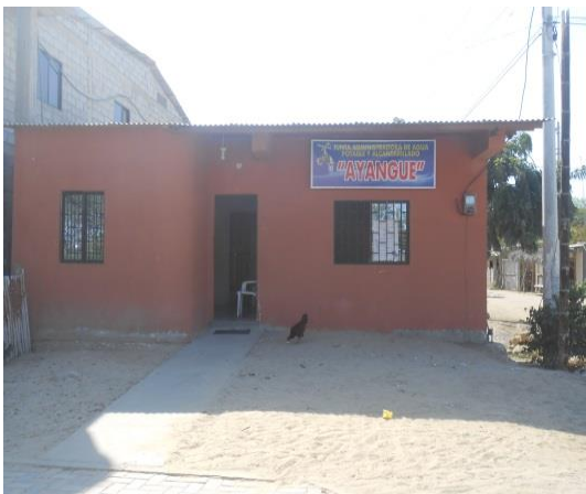
Foto # 5: Junta Administrativa de Agua Potable.
