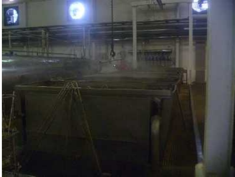
Visita de las instalaciones área de emparrillado.
