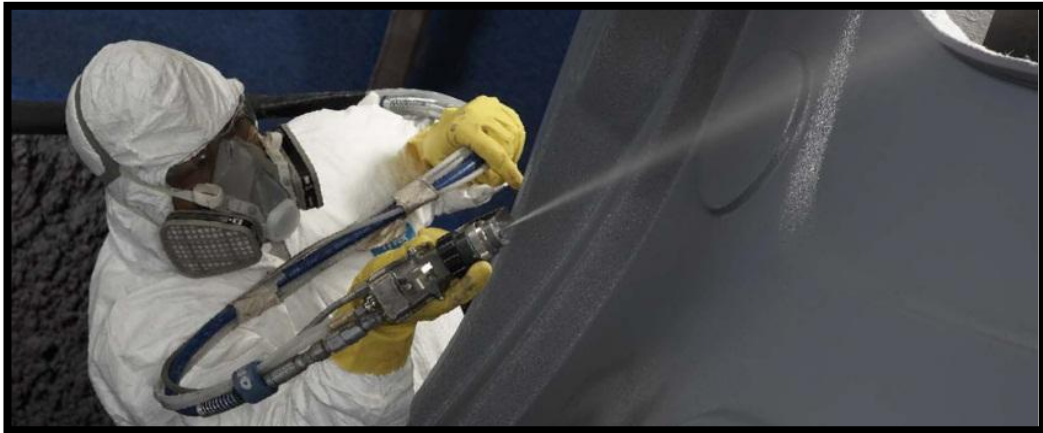
FIGURA N° 10. Moldeo por contacto de inyección.
