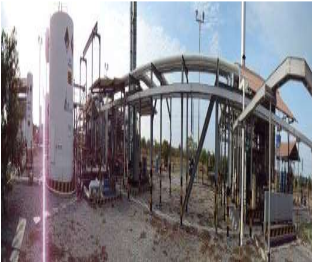
Figura 8: Vista panorámica Planta de Gasolina
