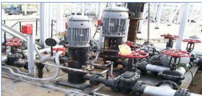
Figura 19: Bombas Centrífugas Verticales Multietapa
