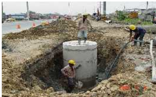
CÁMARA DE INSPECCIÓN PARA AGUAS SERVIDAS
