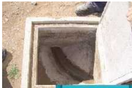
CAJA DE REGISTRO DE HORMIGÓN ARMADO PARA AGUAS SERVIDAS
