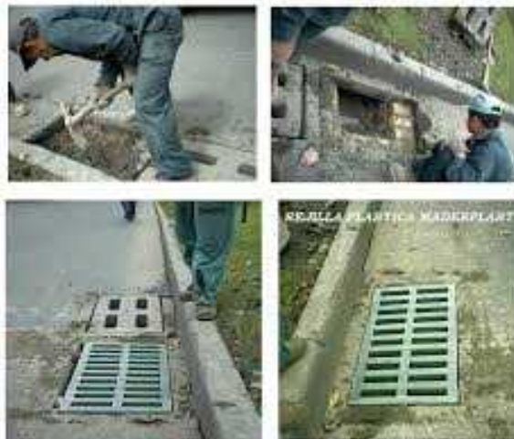
Figura N°38: Sumideros y cunetas.
