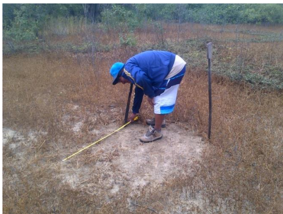
Figura 3A. Medición para calicata.
