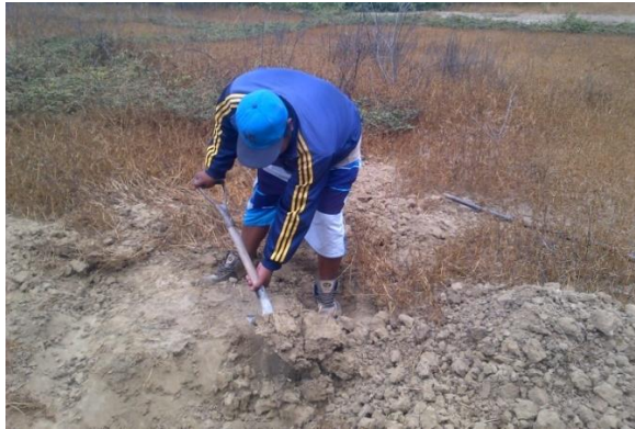
Figura 4A. Realización de calicata.
