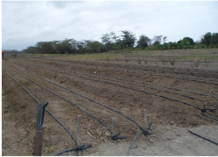
Figura 4A. Construcción de camas
