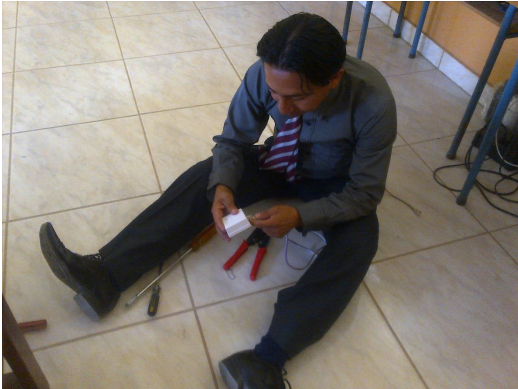
Colocando el cable de red en el cajetín para probar
