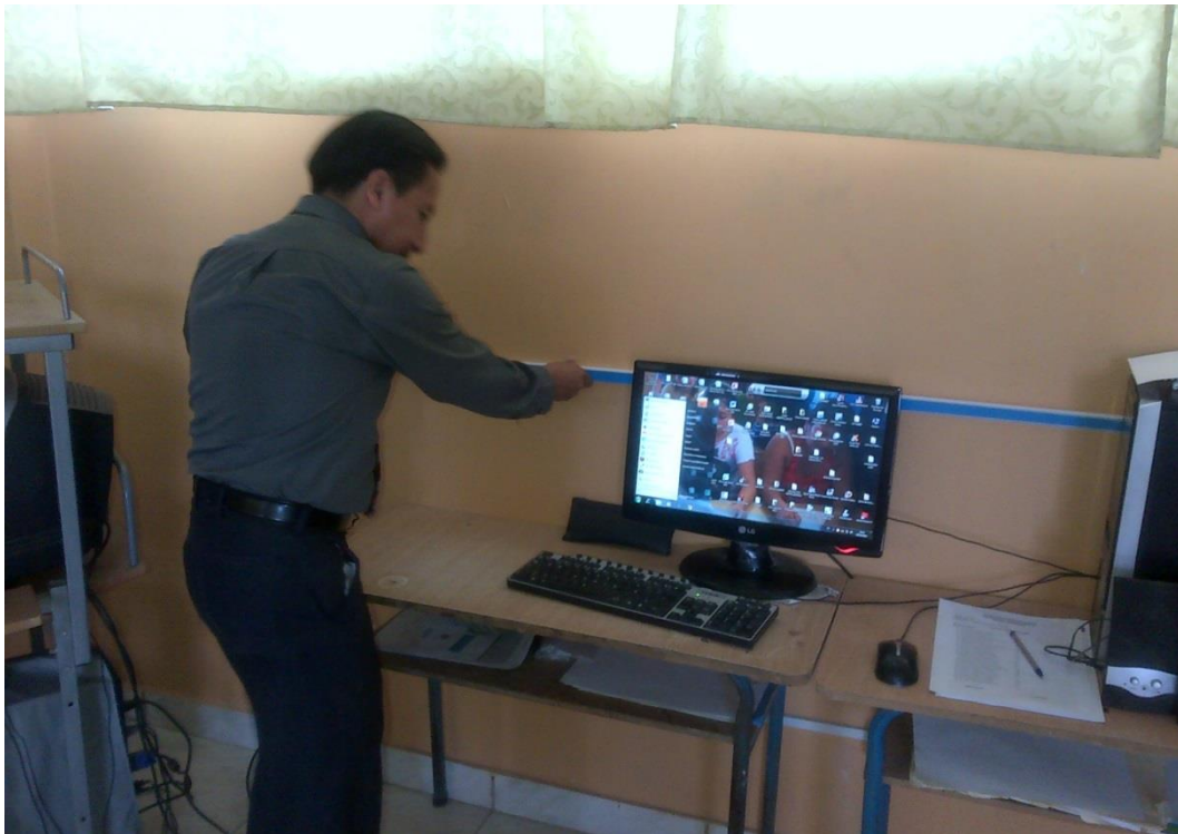
Colocando las canaletas donde pasarán los cables de red
