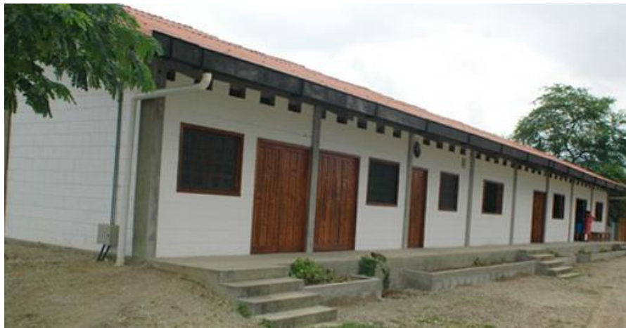
Instalaciones de la Fundación Pro Pueblo
