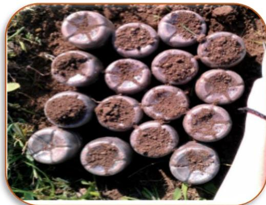
alineación, de tal forma que las botellas de la segunda fila se intercalen con los orificios dejados por la fila de las botellas de la primera fila.
