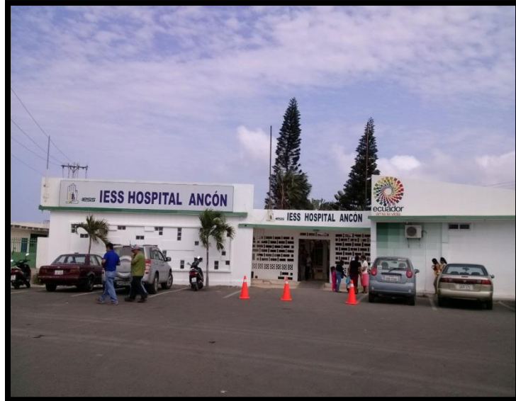
Hospital del Instituto Ecuatoriano de Seguridad Social de la Parroquia San José de Ancón.
