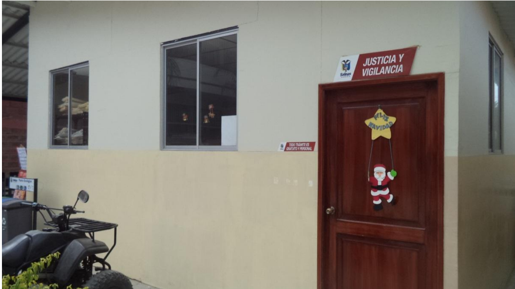
Fotografía 1: El departamento de Justicia y Vigilancia del GAD Municipal del Cantón Salinas, ubicado en la Provincia de Santa Elena Cantón Salinas.
