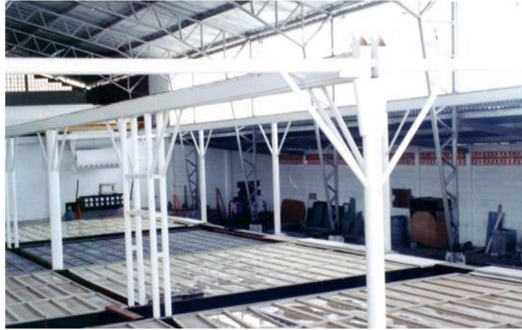
FIGURA # 21 Tanque de enfriamiento.
