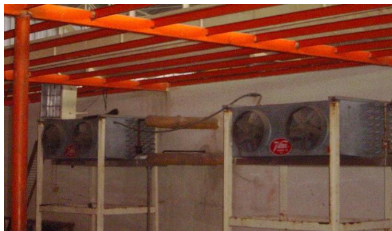
Bodega de almacenamiento.
