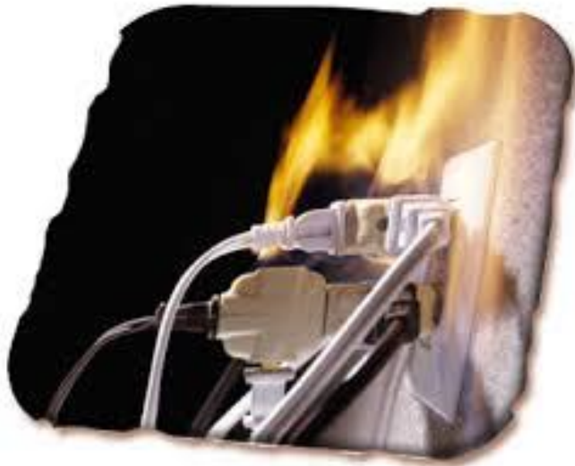
Figura N° 7: Riesgos de incendios
