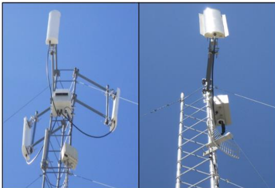
Figura 24: Conexión de la antena utilizando un Pigtail pequeño
