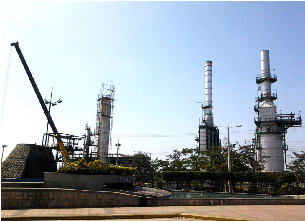
Industria petrolera – Refinería del cantón La Libertad (1)
