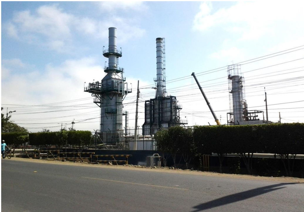
Industria petrolera – Refinería del cantón La Libertad (2)
