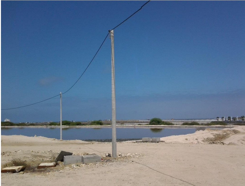
Lagunas de oxidación ubicadas en la vía Punta Carnero (1)
