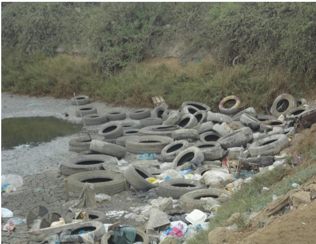
Canal para aguas lluvias lleno de llantas-Sector Velasco Ibarra
