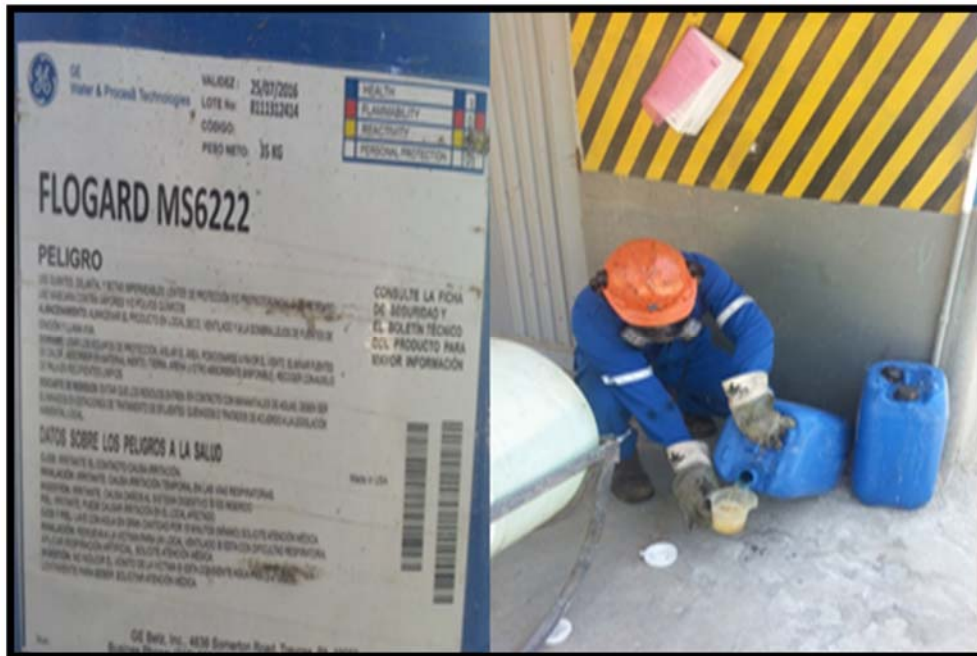
Figura # 23 Preparación Del Químico FLOGARD MS6222
