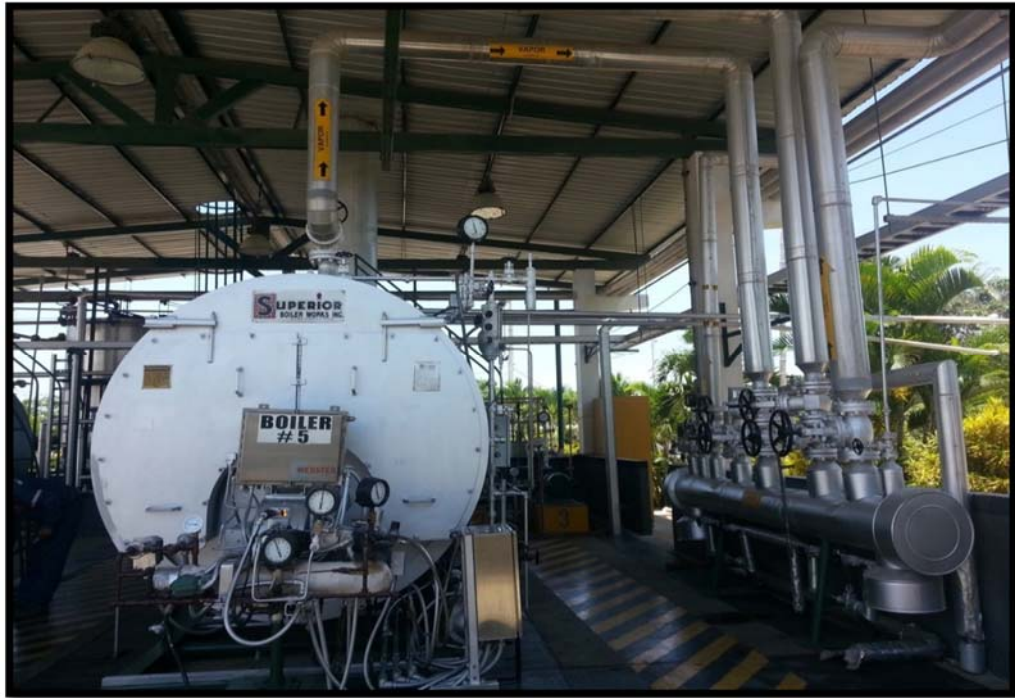
Figura # 16 Calderas Piro-tubulares
