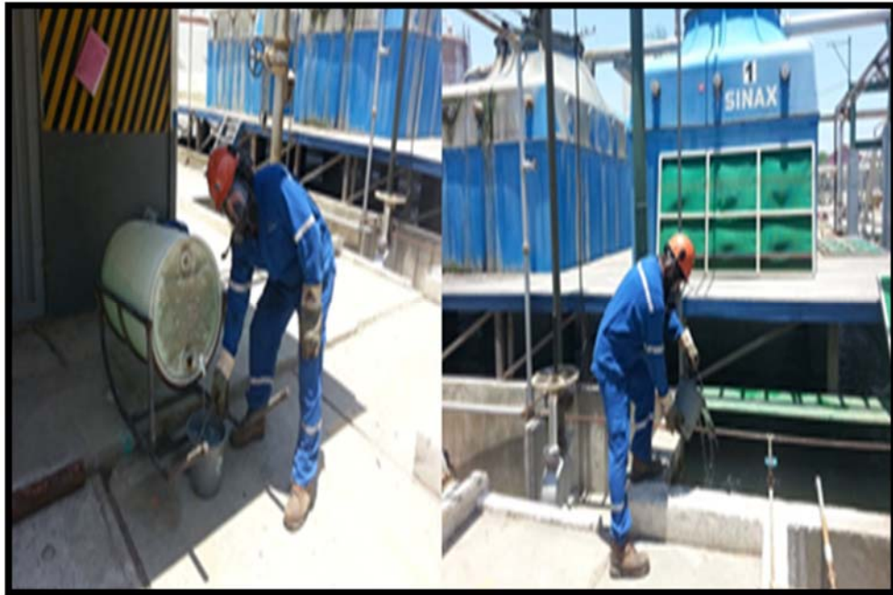
Figura # 24 Preparación Del Químico SPECTRUS NX1106.
