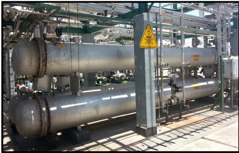
Figura # 29 Intercambiadores Carcasa-Tubo
