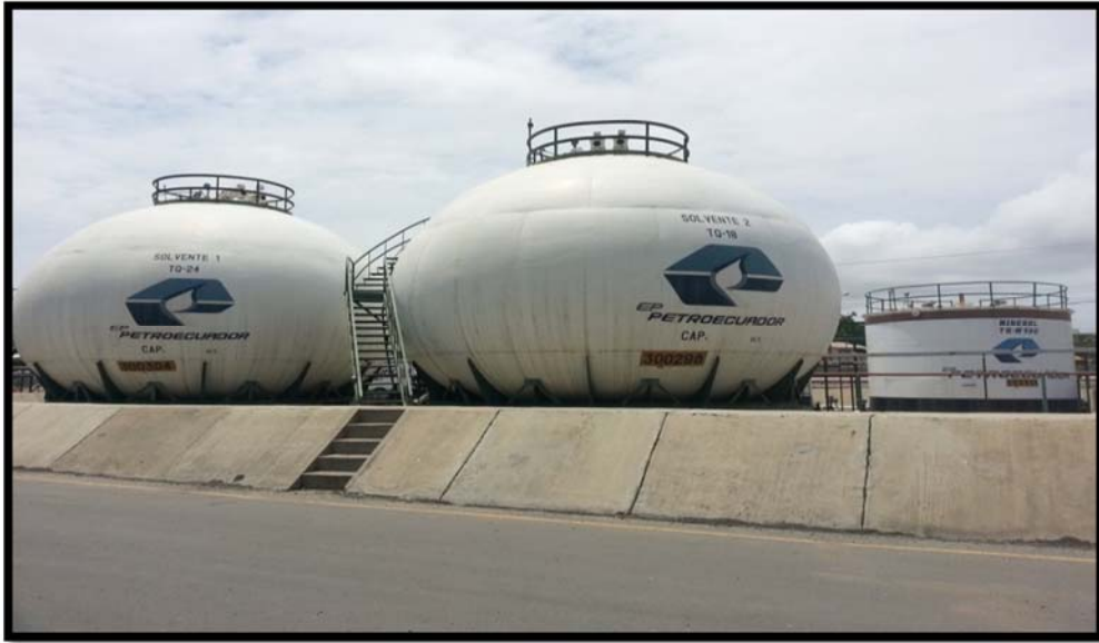
Figura # 37 Lavado De Tanques.
