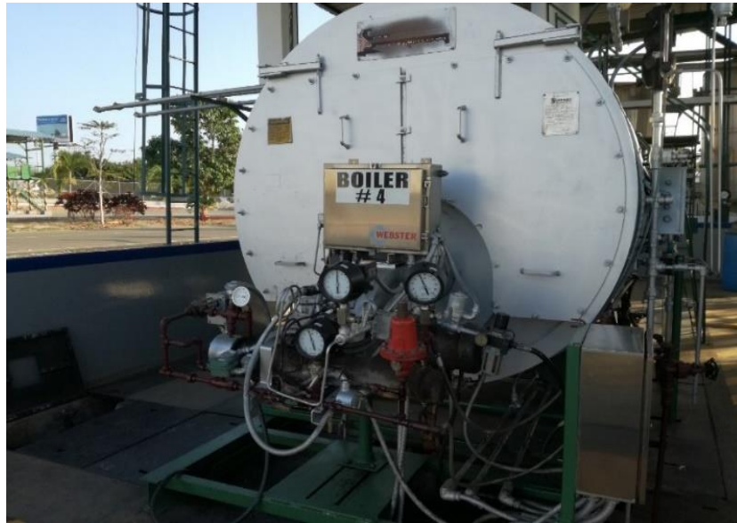
Imagen N° 11. Paralización del funcionamiento de la Caldera #5
