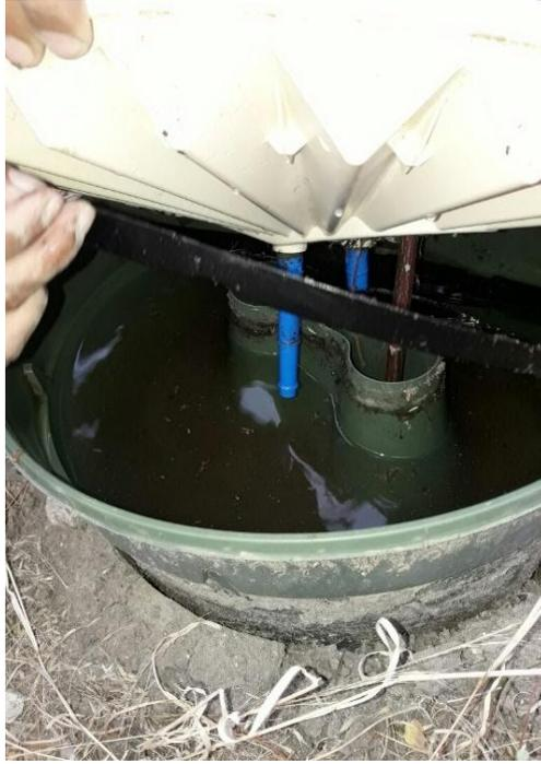
**Figura 3A.- Saturación de mecha dispensadora de agua.**
