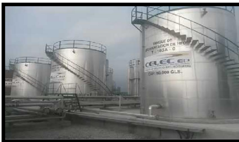
Figura 6: Tanques de Sedimentación de Combustible
