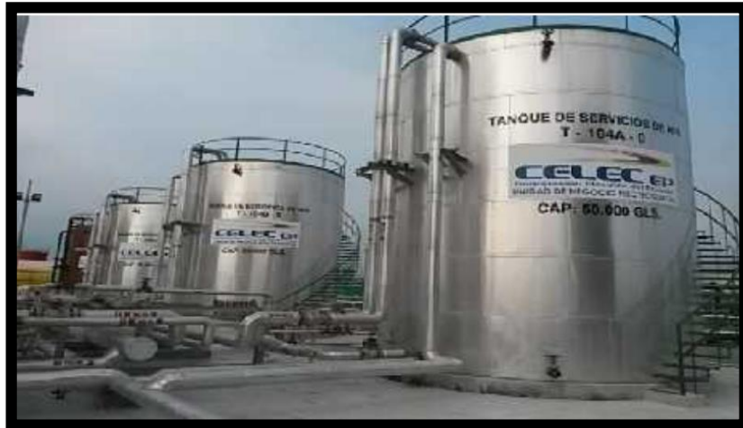
Figura 10: Tanques Diarios o Tanques de Suministro
