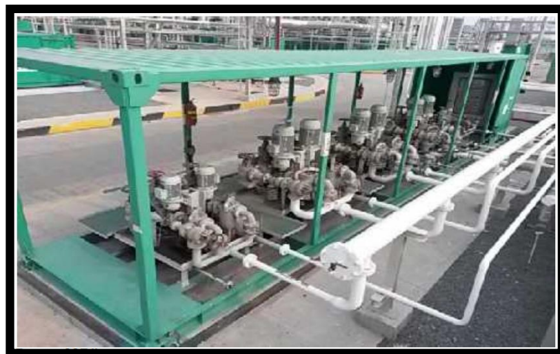
Figura 12: Estación de Bombas de Combustible
