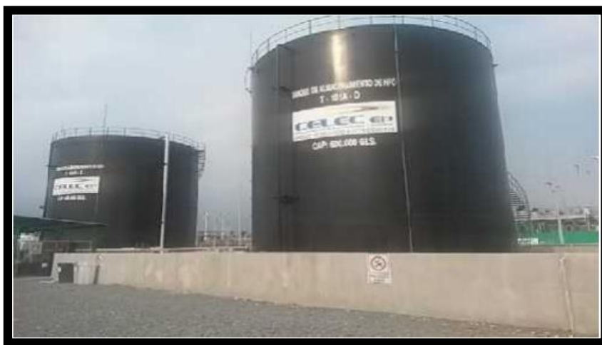
Figura 4: Tanques de Almacenamiento de Combustible
