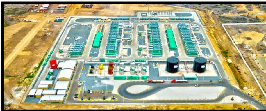
Figura 2: Toma aérea de la estación termoeléctrica.
