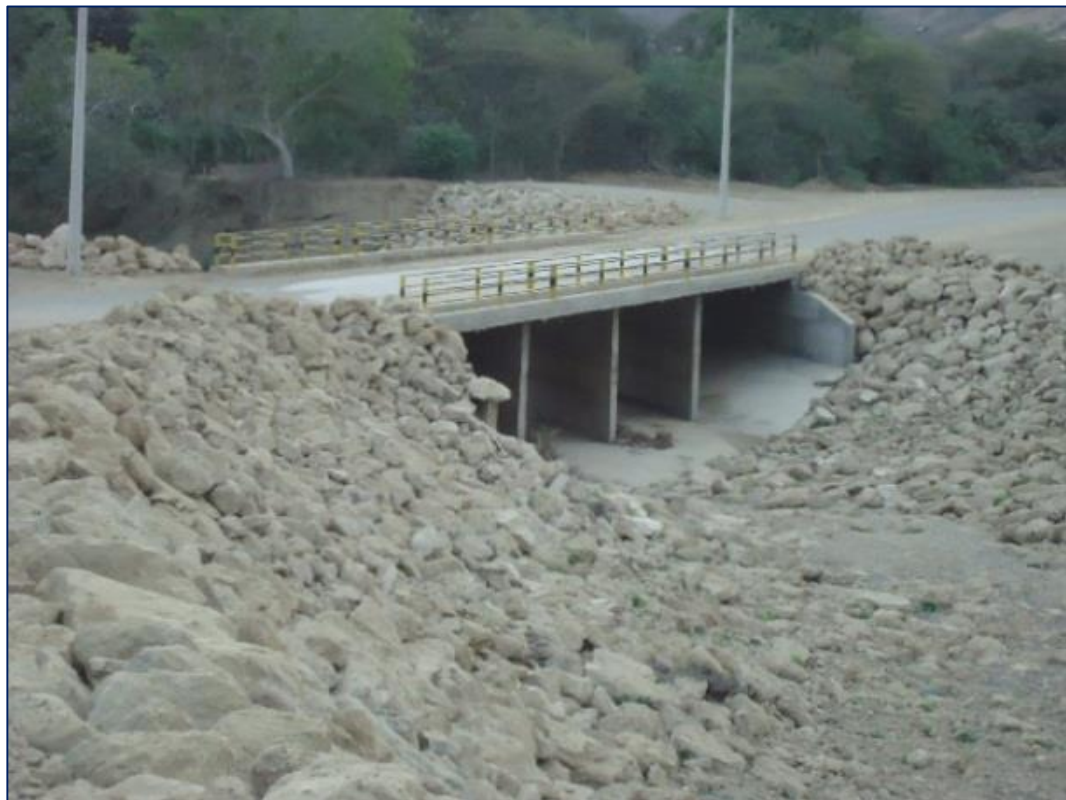
Fuente: Obra gubernamental del Ducto Cajón en la Comuna Manantial de Colonche en estado seco por época de verano Elaborado por: Sixto V. González Castillo
