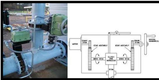
Figura 60. Actuador de Válvula (Web mitecnologico.com)
