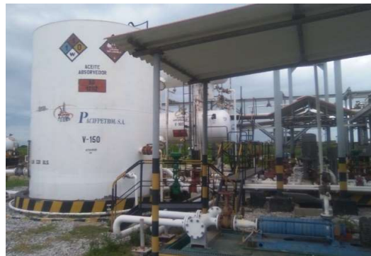
Tanque V-150 y bomba P-250 de aceite pobre
