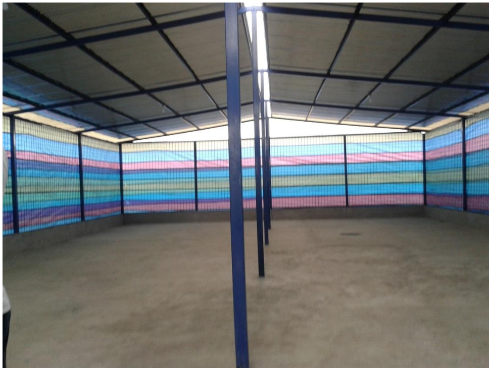
Figura 17A. Verificación de las instalaciones de galpones
