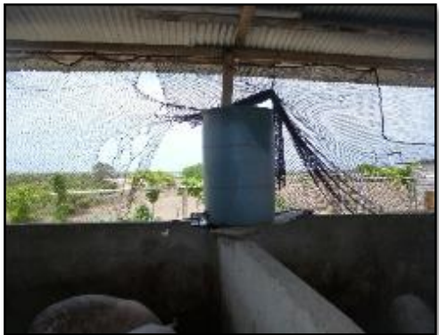
Figura 4A. deposito de agua para bebederos
