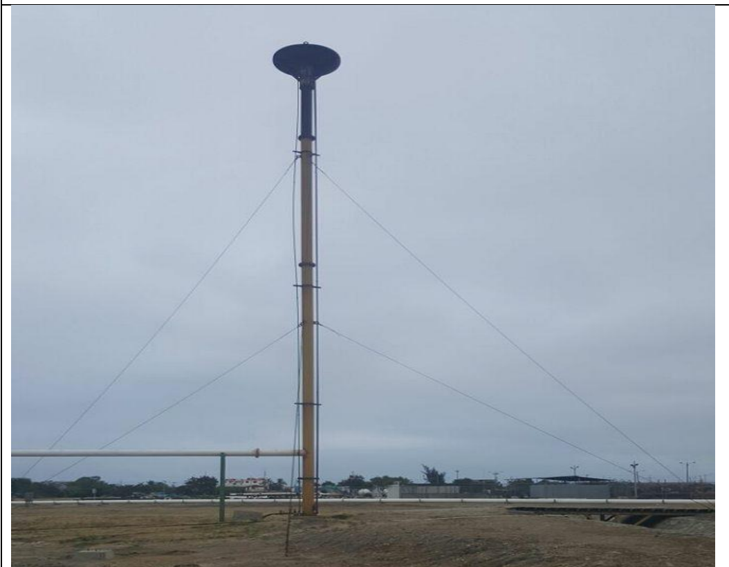
Observación de la TEA de la Refinería La Libertad
