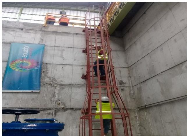
IMAGEN N° 13 RIESGO DE ALTURA
