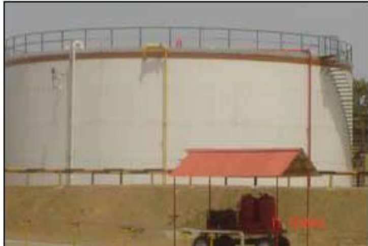
Fig.9: Tanque de techo flexible
