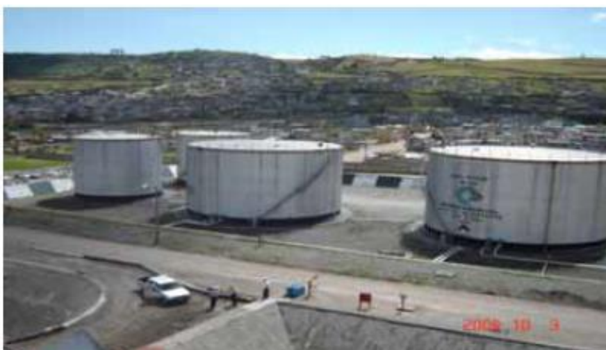
Fig.3: Tanques cilíndricos de techo cónico fijo soportado.
