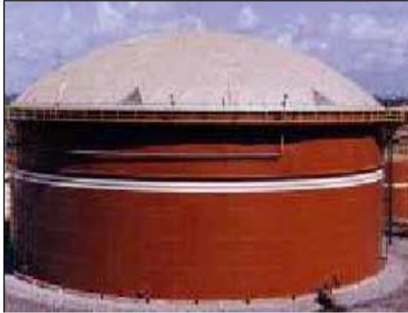
Fig.5: Tanque cilíndrico con tapa cóncava
