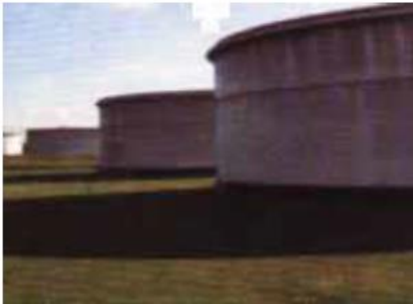
Fig.12: Tanques remachados con techo cónico
