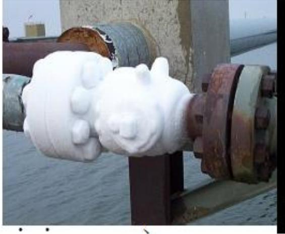
FIGURA 11: Formación de hidrato por baja temperatura del gas (CONGELACION –HIDRATOS)
