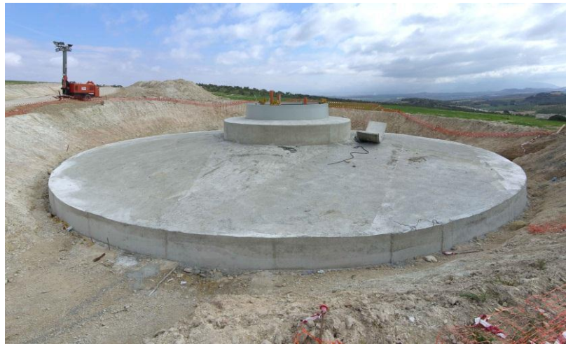
Figura N° 14 Construcción de plataformas de apoyo y cimentación
