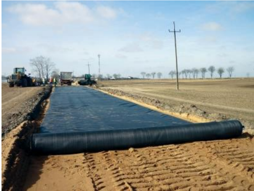
Figura N° 13 Construcción de accesos.
