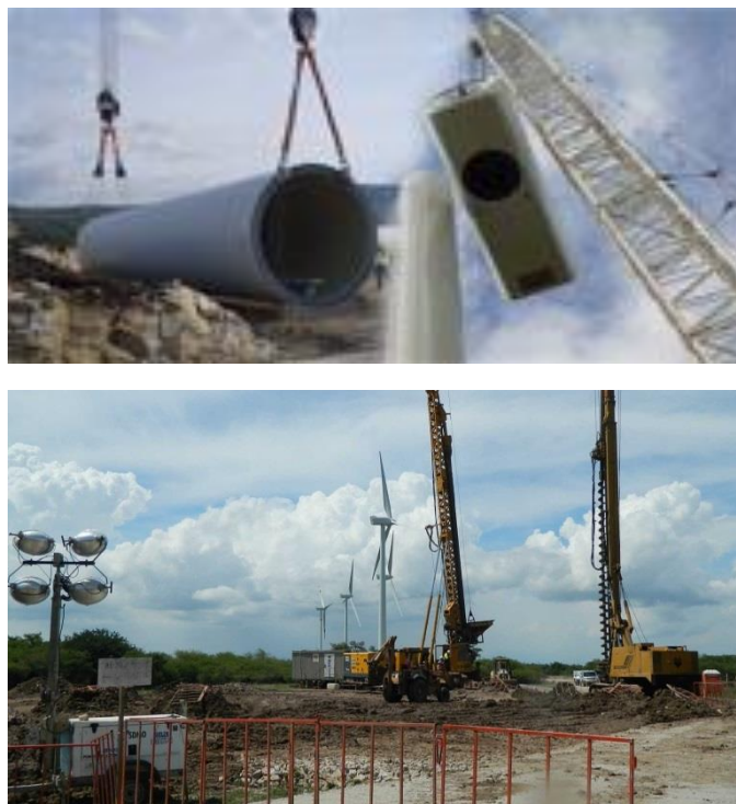
Figura N° 19 Fase de retiro
