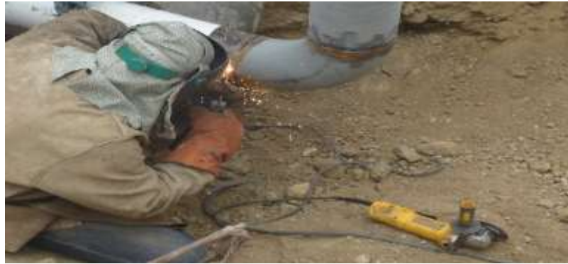
GRÁFICO #31 PULIDORA INADECUADA
