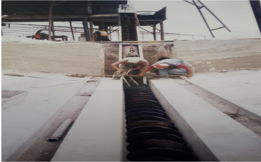
Fuente: Empresa Alterpes C.A., Construcción de la Recepción de materia prima.
