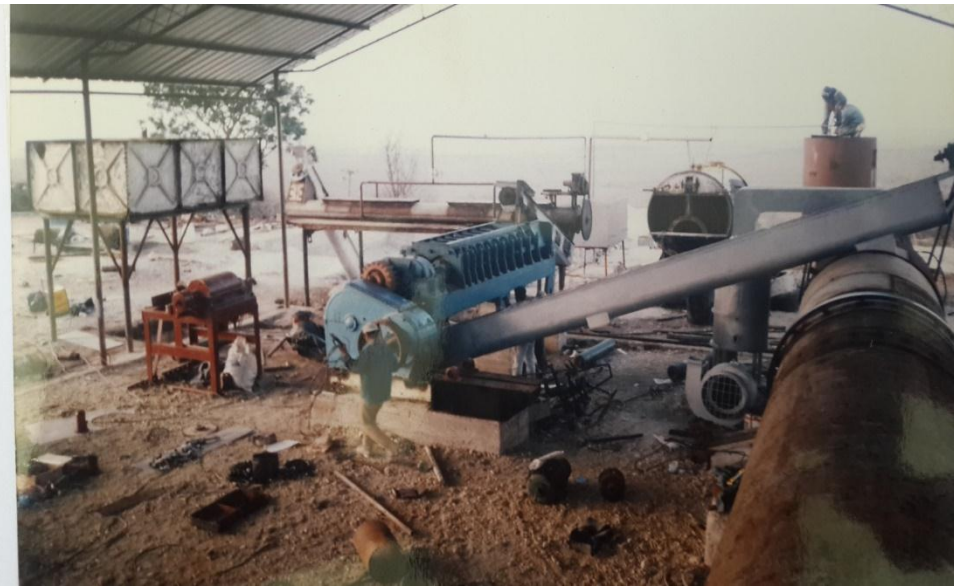
Fuente: Empresa Alterpes C.A., Área de Proceso, montaje de maquinarias, Prensa – separadora de sólidos y secador
