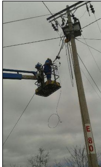
Imagen 33. Reparación eléctrica. (Líneas sulfatadas)
