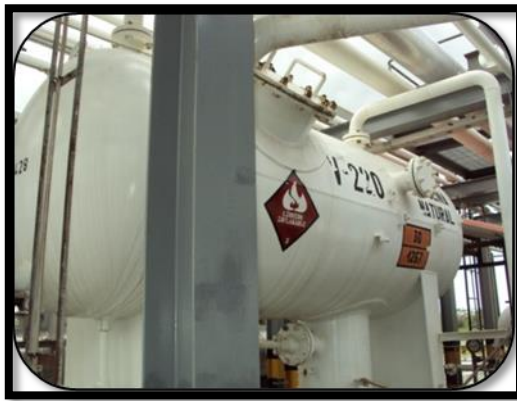
Imagen 11. Tanque de reflujo
