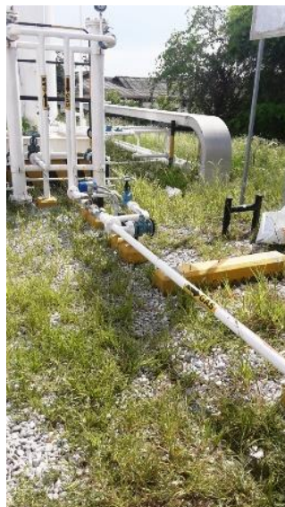
Imagen 38. Sitio donde se instalaría analizador de oxígeno
