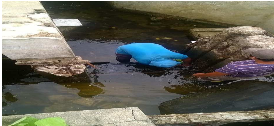
Imagen N°1 Sellado y limpieza de compuerta.
