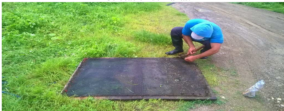
Imagen N° 5 Colocación de mallas.
