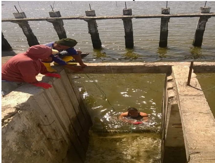
Imagen # 17 Retiro de tablas de compuerta de salida.
