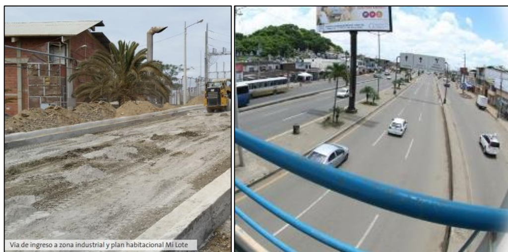
Figura 1. Vías estabilizadas con cemento.
