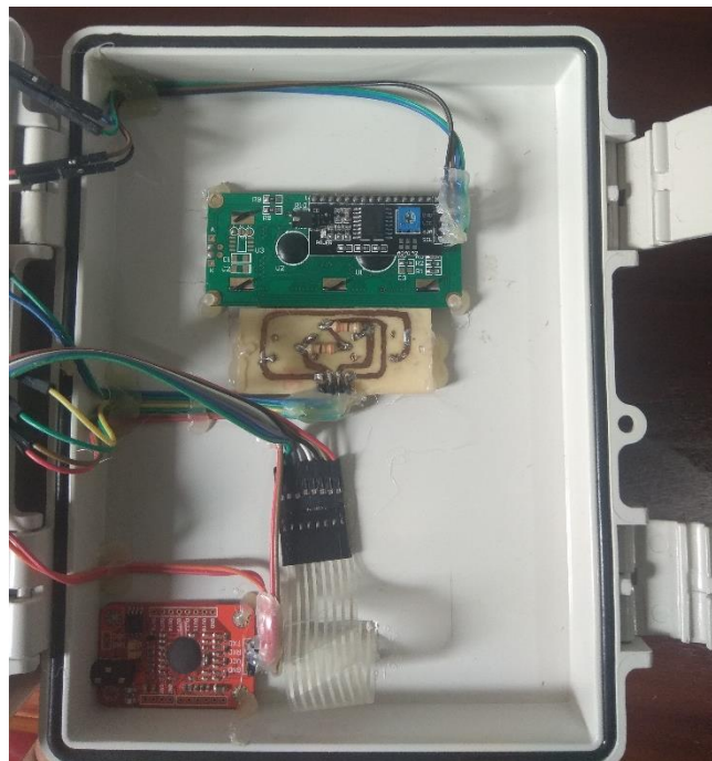
Figura 33. Interior del panel de control. Elaborado por el autor.
