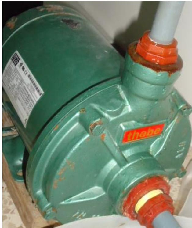
*Figura 17 Bomba centrífuga THEBE para extracción y bombeo de la planta*
