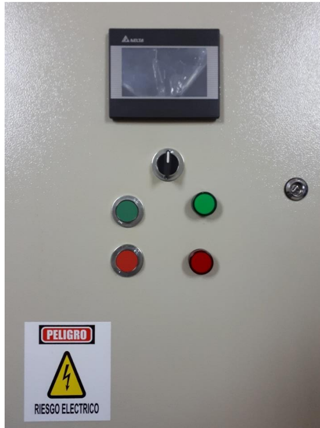
Figura 33. Diseño de la puerta del tablero eléctrico
