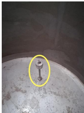
Figura 25: Ubicación del sensor flotador de 15 cm
