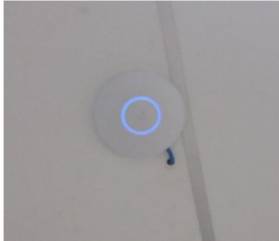
Figura 59: Instalación de antena
