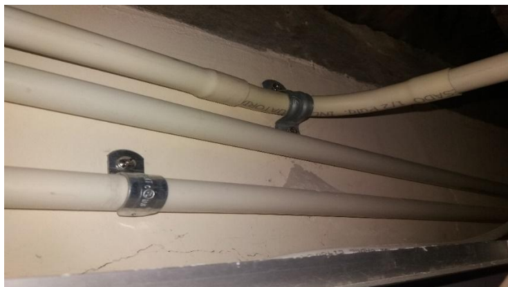
Figura 60: Instalación de canaleta PVC para profesión del cable.
