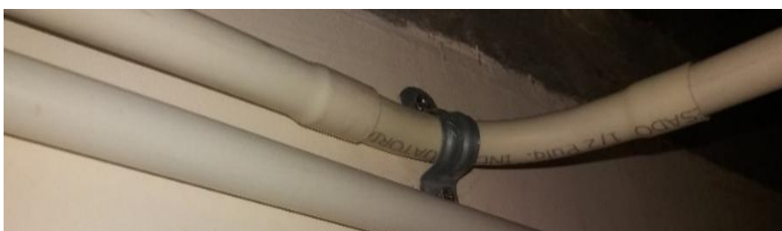
Figura 30: Tuvo PVC para instalación de cables.
