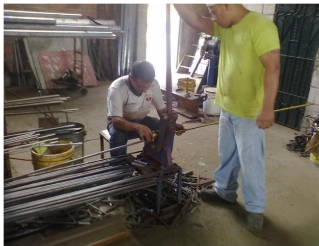
Imagen 13: Medición y corte de varilla
