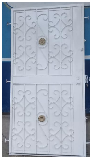
Imagen 10: Acabado de puerta contrapuerta
