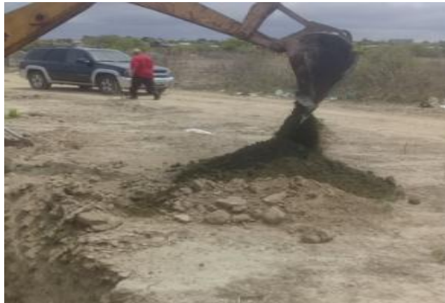
Figura 24: Arenas asfálticas- minas de Achayán Fuente: Elaborada por los autores
