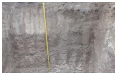
Figura 23: Calicata 1 Fuente: Elaborada por los autores
