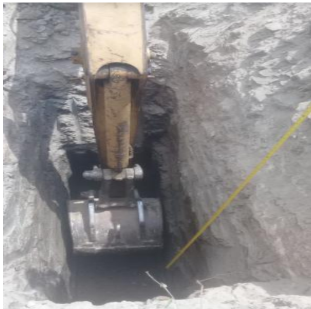
Figura 25: Arenas asfálticas a 4 metros de profundidad Fuente: Elaborada por los autores.
