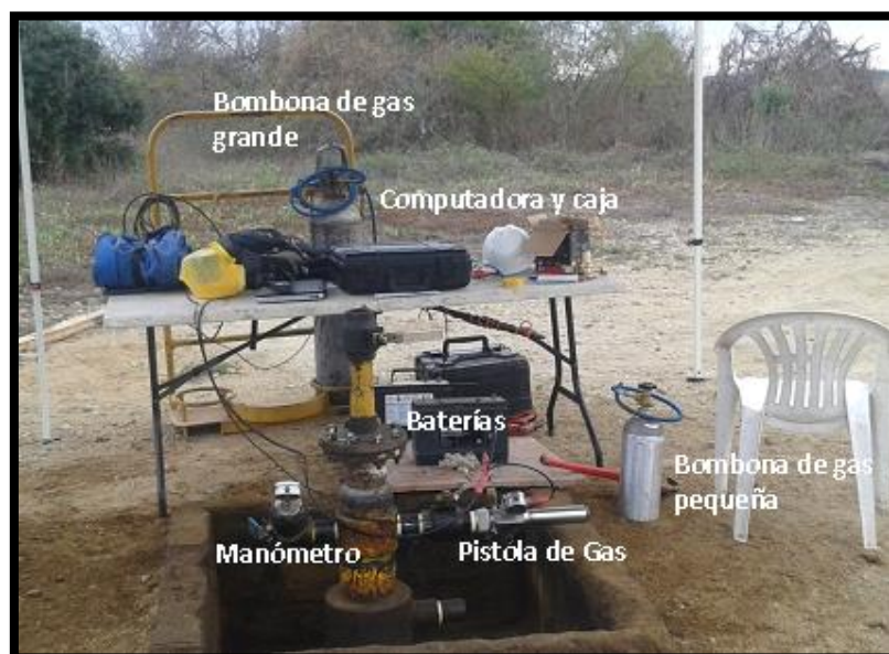
FIGURA # 14 .- COMPONENTES PARA PRUEBA DE PRESIÓN TRANSIENTE – POZO ANC1260
